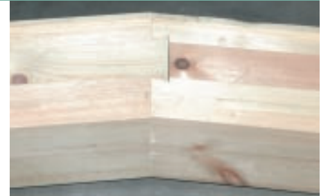
Eckverbindung des Vierkantblocks
